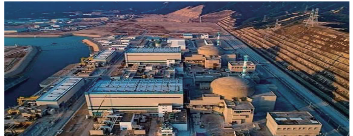
福建漳州云霄核电站1、2号机组项目
