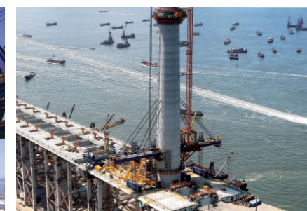
昂船洲大桥——香港 重型起吊
