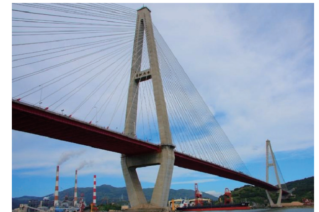
闽江青洲大桥 ①
