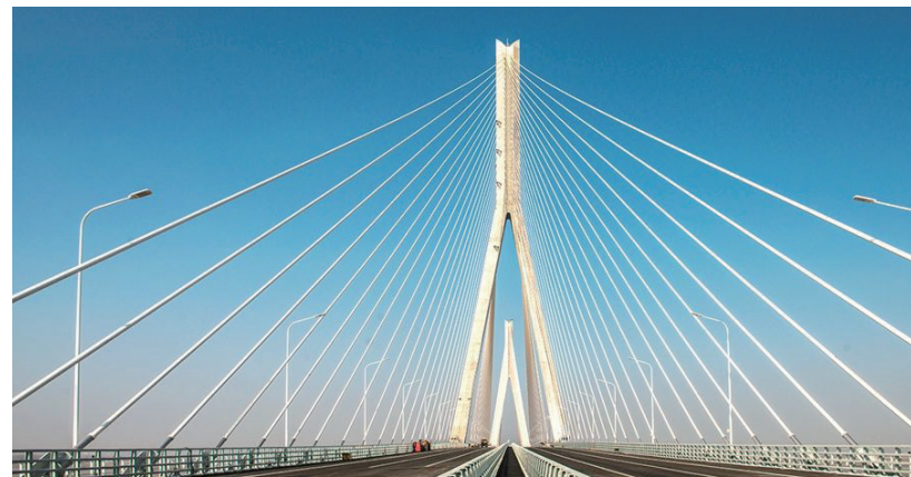
① 望东长江公路大桥
