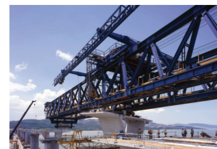
深圳西部通道——香港 架桥机施工
