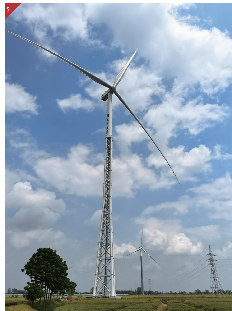
图5：浙江华东新能科技有限公司-道仁新能源涡阳县风电项目（格构塔）
