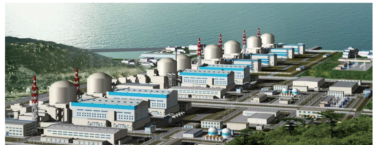
田湾3、4、7、8机组项目
