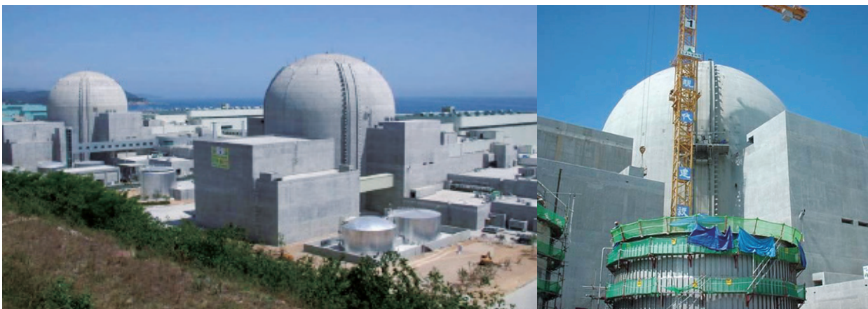
韩国核电站安全壳项目
