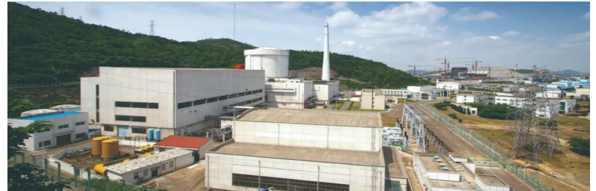
中国第一座核电站—秦山核电站（一期）项目
