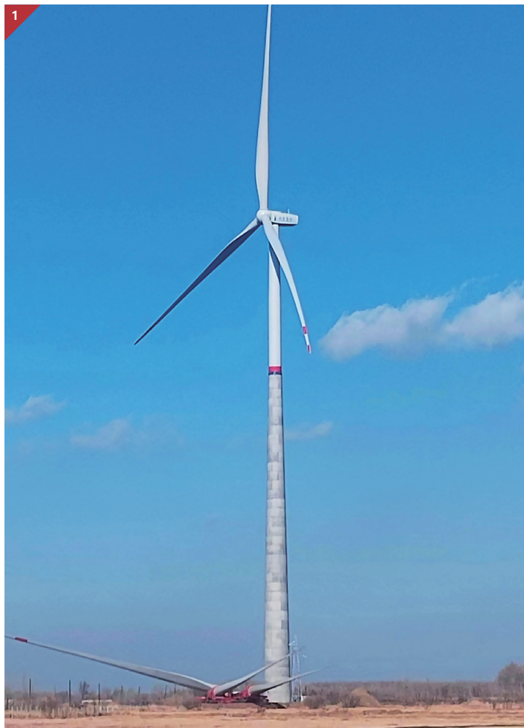
图1：浙江巨杰科技发展集团有限公司—禹城风电项目
