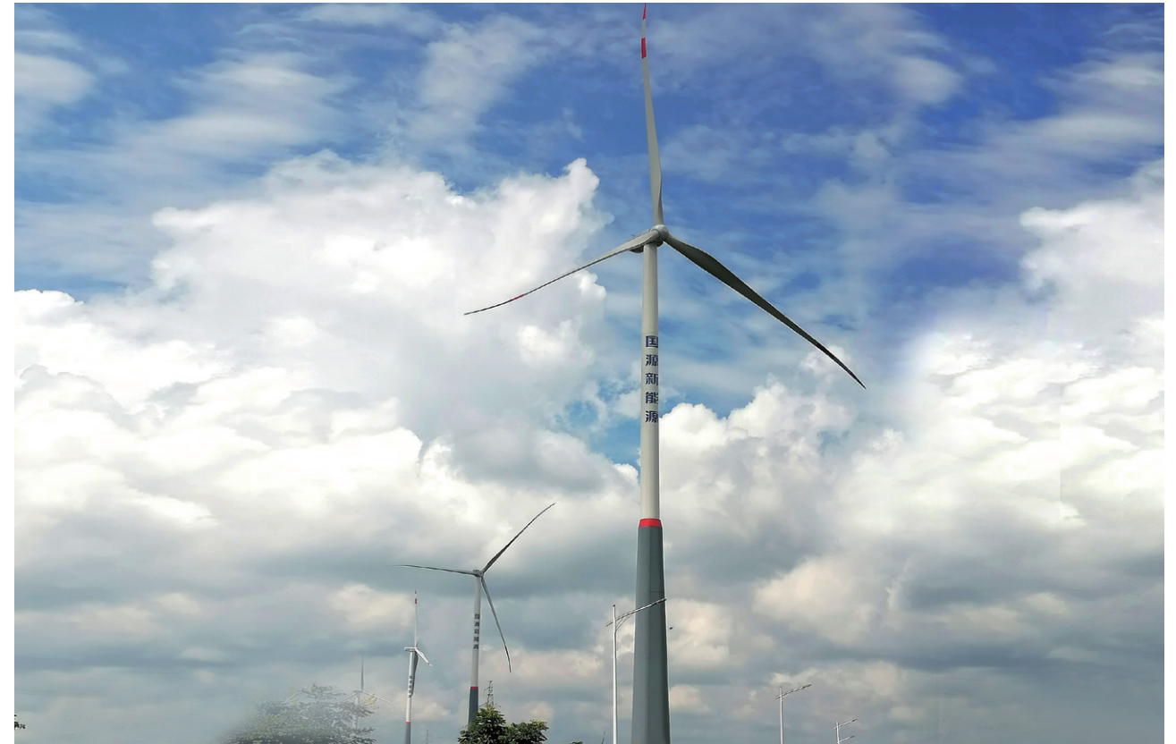
中国船舶重工集团海装风电股份有限公司——宝应风电项目
