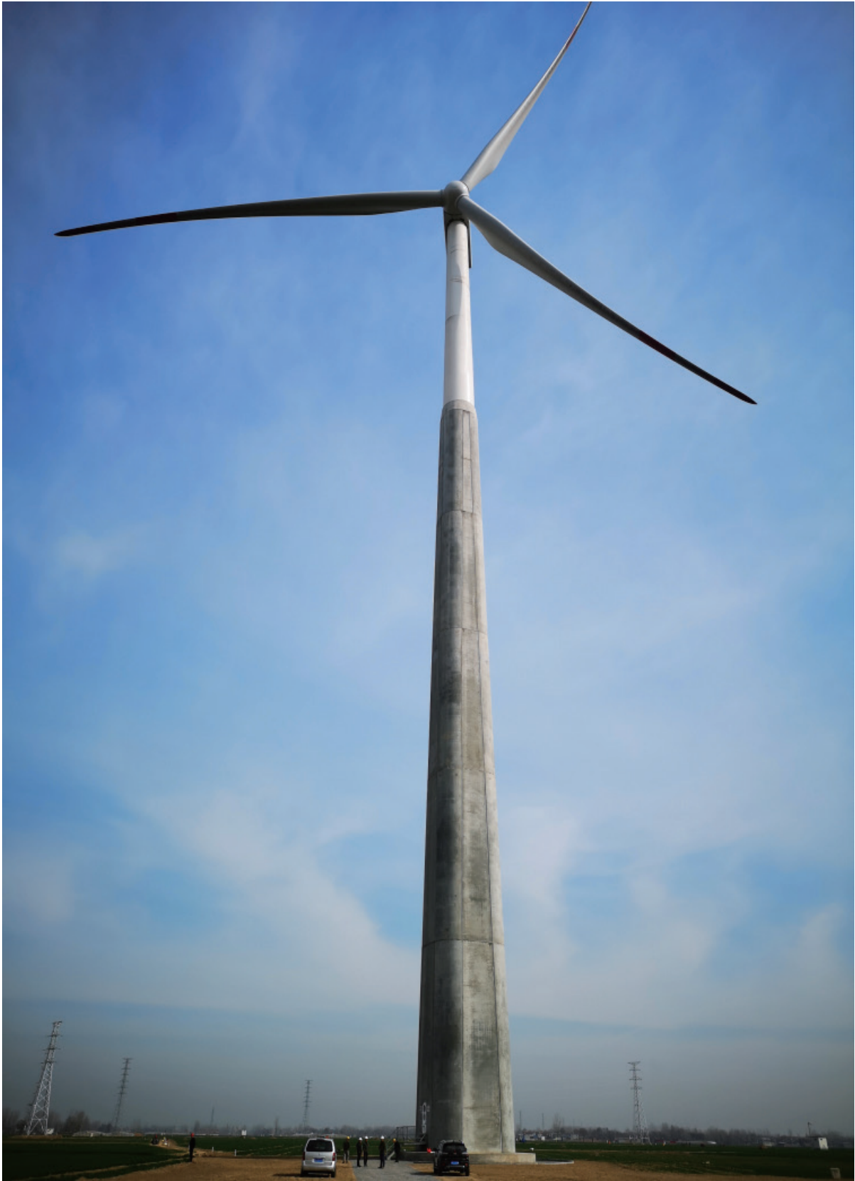
中国船舶重工集团海装风电股份有限公司——华电延津风电项目
