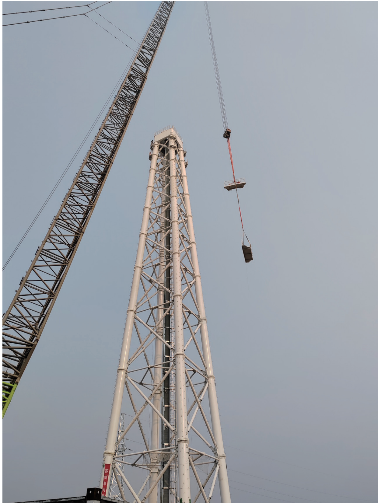
中国船舶集团海装风电股份有限公司—山东中明德州乐陵风电项目（全球首台165米级格构式塔架）
