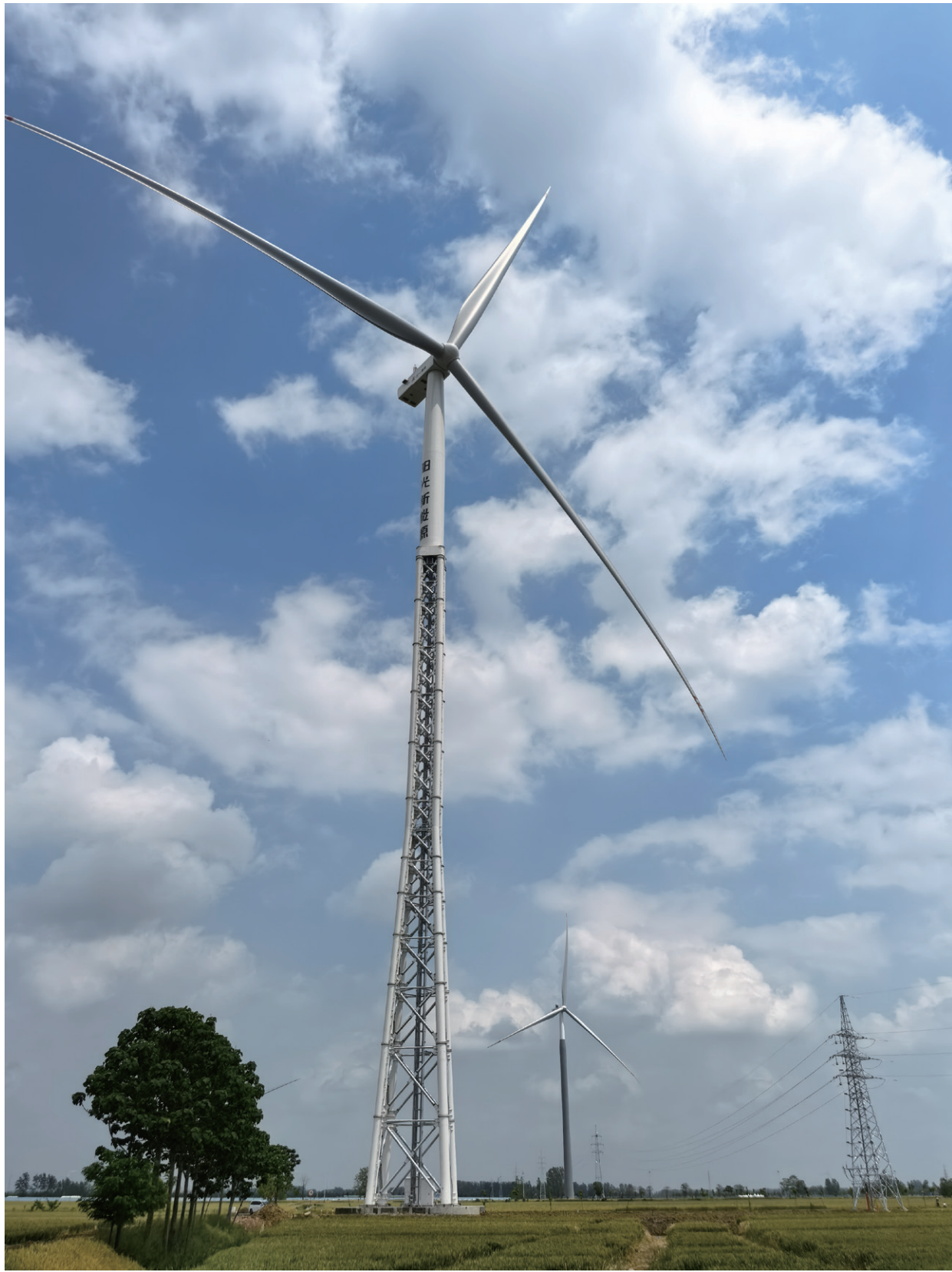
⌚ 浙江华东新能科技有限公司——道仁新能源涡阳县风电项目（国内首台叶片净空自适应格构塔）
