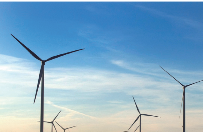
上海电气集团股份有限公司——甘肃张掖风电项目
