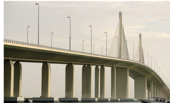
Hodariyat Bridge, 阿联酋
