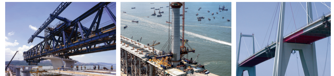
深圳西部通道——香港 架桥机施工
