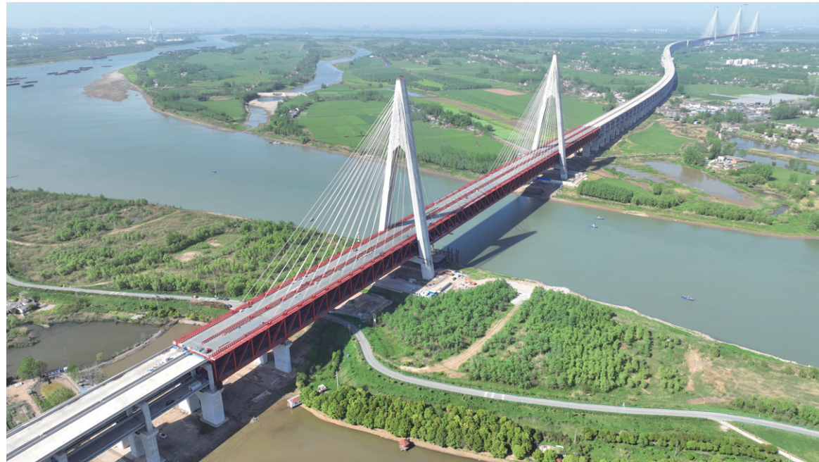
马鞍山长江公铁大桥副汉航道桥—SSI 2100EW钢绞线斜拉索体系
