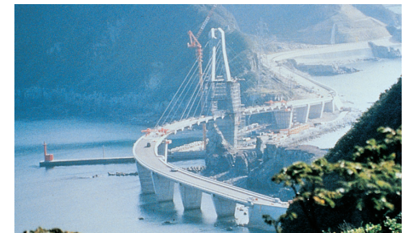
Koshiki Daimyojin Bridge, 日本
