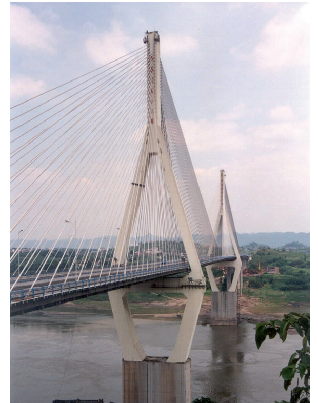
马桑溪大桥——中国重庆 (2001) SSI 2000 斜拉索体系国内首次使用
