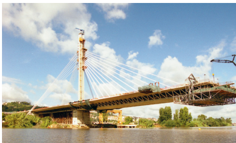
Ponte Europe Bridge, 葡萄牙
